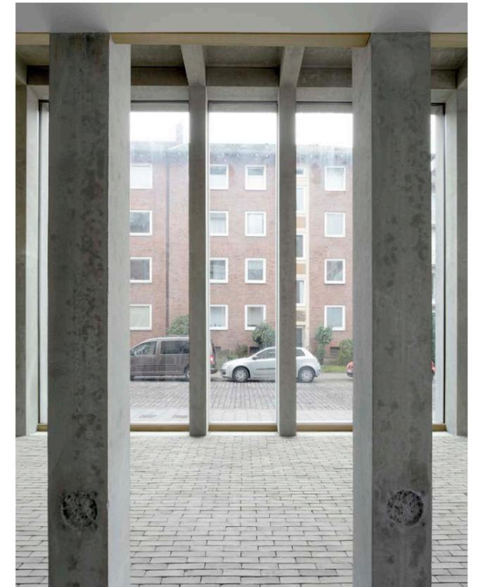
Einfüllstützenansatz selbstverdichtender Beton
